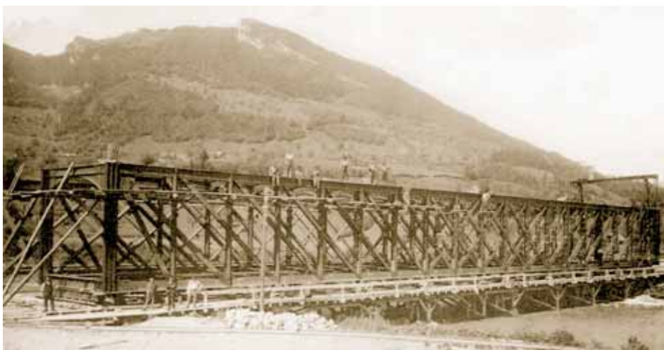
Montageplatz der Muotabrücke. Fotos: Sammlung E. Schmied
