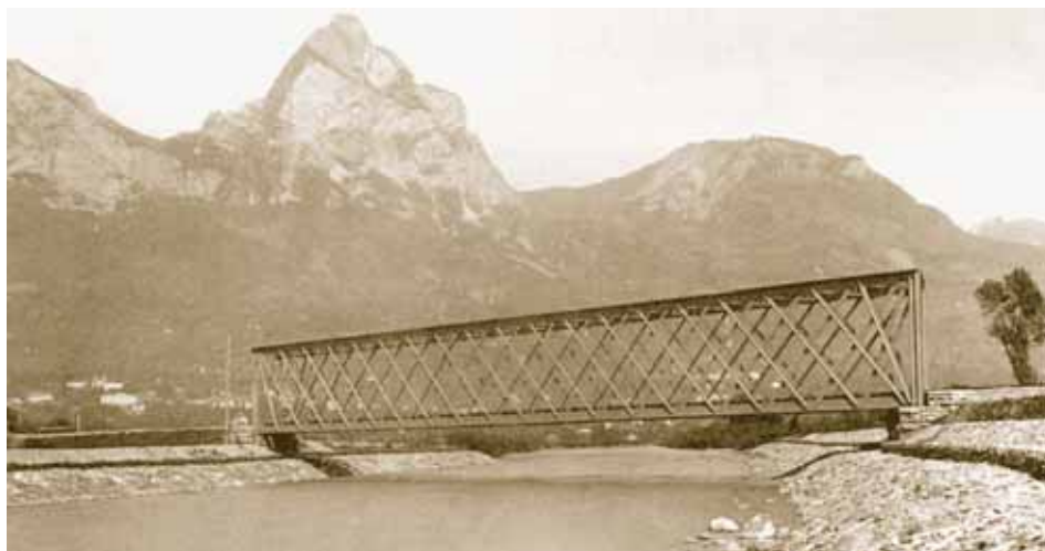
Muotabrücke 1882 1. Spur (Unterwasserseite), Bauausführung: Fa. Bell in Kriens LU.
